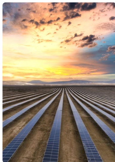
阿塞拜疆戈布斯坦地区(Area 60)光伏电站项目
