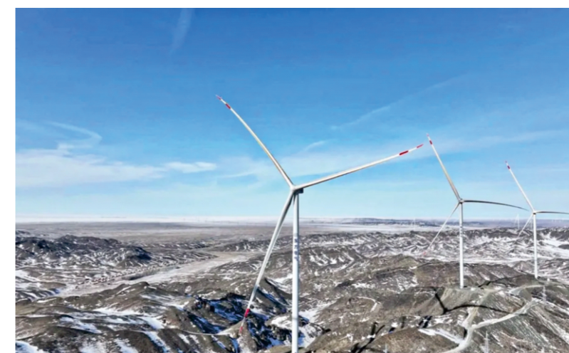
新疆木垒风电工程项目
