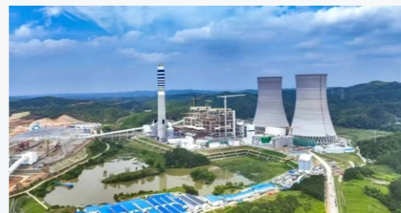
东方电气首台成套1000兆瓦二次再热机组在大唐新余投运 630℃超超临界二次再热国家电力示范项目
