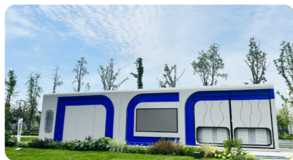
绿色低碳总部示范园区——光储氢综合能源项目
