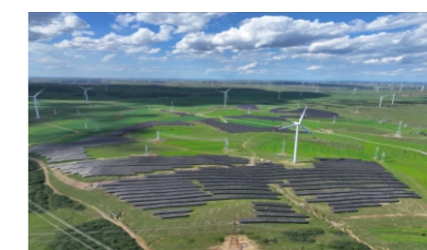
张北100兆瓦光伏项目
